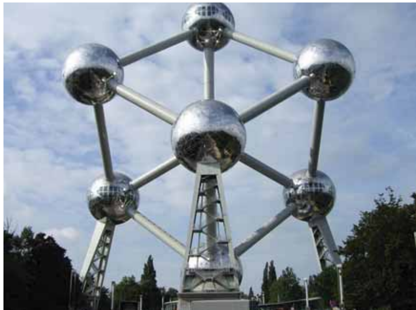
Figur 0.1: Atomium är Bryssels landmärke och detta visar järnatomens kubiskt rumscentrerade struktur (BCC). Konstverket är 105 meter högt och gjordes ursprungligen i aluminium för Världsutställningen 1958. 2005 ändrades beklädnaden till syrafast 4404 (1,2 mm plåt) från Aperam. Foto: Thomas Pauly, Euro-Inox [11].
